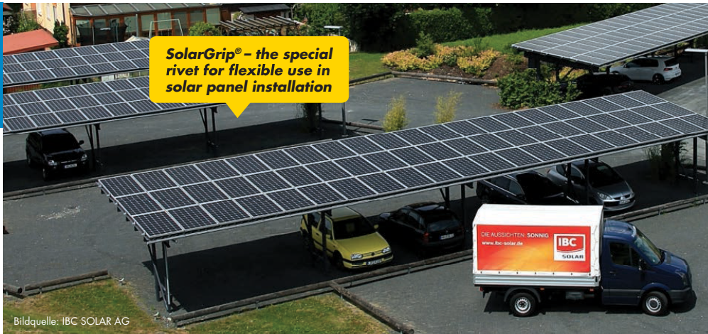
Bildquelle: IBC SOLAR AG
